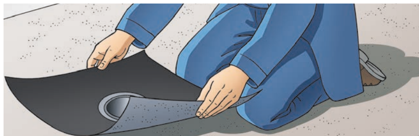
Obr. 3 – 19 Umístění utěšňovací manžety
