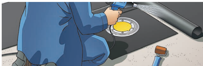
Obr. 3 – 21 Svařování izolačního pásu z EPDM horkým vzduchem
