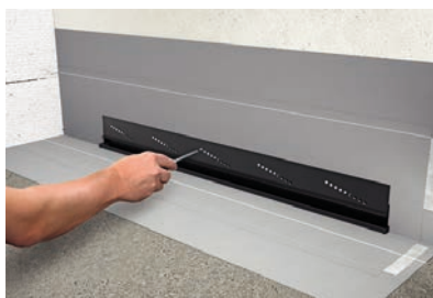
Obr. 3 – 31 Stěnový žlábek – utěšňovací příruba
